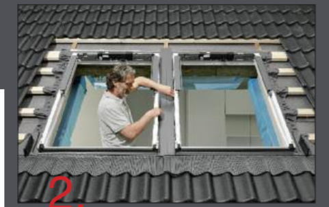
Die neue, patentierte Mittelrinne kann flexibel je nach Fensterabstand um maximal sechs Zentimeter bis an das rechte Fenster herangeschoben werden.
