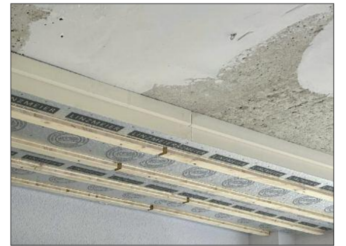
Neben der kurzen Montagezeit bietet die neue Innendämmung LINITHERM PAL UK eine minimale Aufbauhöhe dank hoher Dämmeffizienz (λ 0,023). Die raumseitige Beplankung ist frei wählbar, die elektrische Ausstattung (LED-Spots, Steckdosen etc.) lässt sich schnell und sicher einbauen oder nachrüsten.
