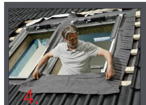
Auf der äußeren Seite werden die Anschlussschürzen wie bewährt plissiert sein; der zwischen den Dachfenstern liegende Bereich wird für eine leichtere Verarbeitung künftig glatt gefertigt.
