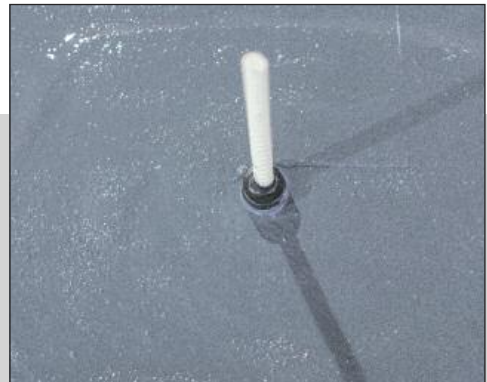
schicht blieb sie zudem begebar und bildete gleichzeitig einen griffigen Untergrund für den Flüssigkunststoff. Alle Randabschlüsse der Bahnen sowie
