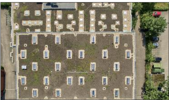
Das Dach wurde neu gedämmt sowie abgedichtet und mit einer extensiven Dachbegrünung versehen. Für die natürliche Belichtung der großen Halle sowie der Nebenräume wurden Oberlichter verbaut.
