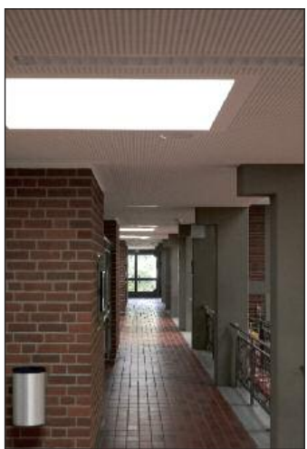
Flure und Nebenräume: Das Flachdachfenster FDF neo mit kommt durch seine geradlinige Optik und die wärmebrückenoptimierte Gesamtkonstruktion mit thermisch getrenntem Profilsystem und hochwertiger Wärmeschutzverglasung besonders gut zur Geltung.
