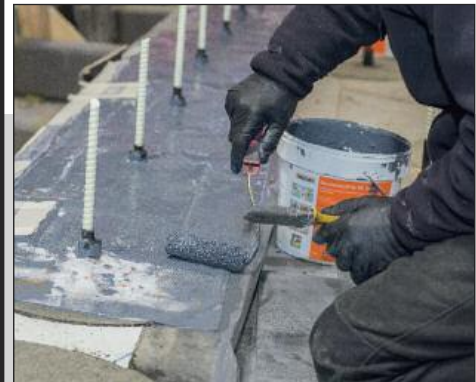
Der zweischalige Twist erhielt auf seiner Tragschale eine hochwertige, kaltselbstklebende Elastomerbitumen-Abdichtungsbahn mit besonders siche-
