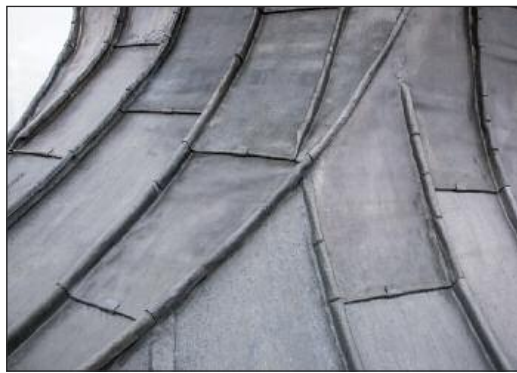
Die vertikalen Längsseiten der Schare auf den Hauben sind durch Hohlwulste verbunden. Die Querverbindungen sind jeweils 10 Zentimeter versetzt, um Materialdoppelungen zu verhindern. Längsfalze der obersten Zwiebel verlaufen entlang der Grate. In der unteren Wölbung folgen sie den Konturen.
