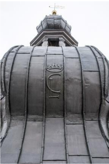
Die historischen Bleibleche sind über Jahrhunderte nur geflickt worden. Darunter konnte die eingedrungene Feuchtigkeit ungestört das Eichenholz der Turmkonstruktion zersetzen.
