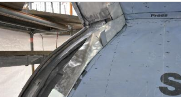
Zur indirekten Befestigung der unterseitig verzinnnten Bleischare kommen haltbare Edelstahlfalte- und -schrauben zum Einsatz.
