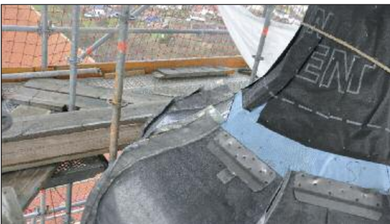
Zur effektiven Windsogsicherung werden die Schare mit durchgehenden Nagelreihen befestigt.
