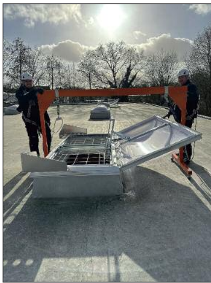
Das mobile Absturzicherungssystem KingSafe für 2 eignet sich als flexible Lösung für die Sicherung von zwei Personen gleichzeitig auf dem Dach.
