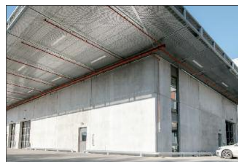
Der weite Dachüberstand bietet auch vor der Halle Schutz.
