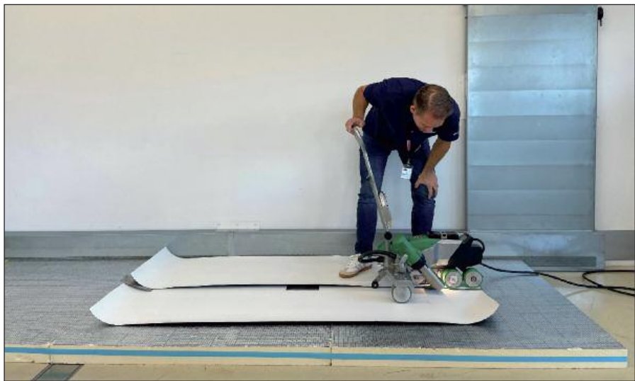
Bild links: Testverschweißung mit dem neuen Leister VARIMAT 700. Bild oben: Original Leister Schweißnaht-Prüfschab-lone. Bild rechts: Mittels einer Schweißnaht-Prüfschablone wird ein Schnittbild zur Prüfung erzeugt.
