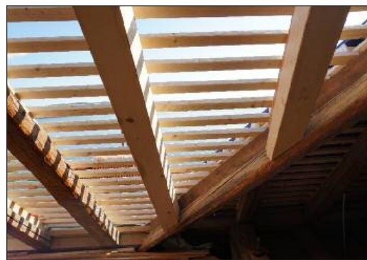
Der Dachstuhl wurde in Teilen ausgetauscht, das Dach komplett frisch eingelattet.
