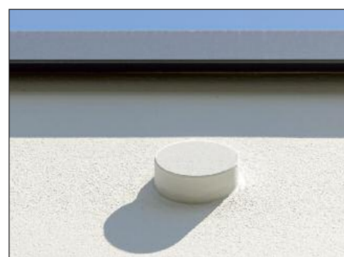
Damit die Entwässerung das Fassadenbild nicht stört, verlaufen die Falleitungen hinter der Fassade. Nur für die Entlüftung der Rohre ist ein Durchbruch notwendig. Dies ist elegant mit einer „Wuppertaler Blende“ im Farbton des Fassadenputzes gelöst. Von unten ist die Blende geschlossen und fügt sich so harmonisch in die Fläche ein.
